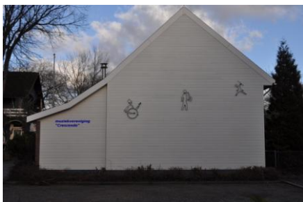
Nieuwe voorgevel Crescendo gemaakt door Veenman en Vink uit Hillegom.
